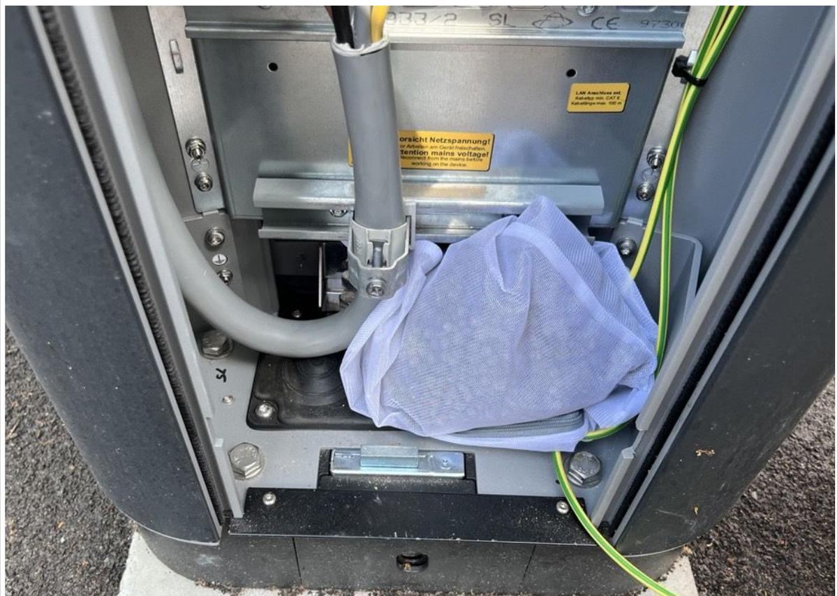
Bei Ladesäulen mit integriertem HAK (TEP4 HAK) empfiehlt Technagon das Sockelfüllmaterial jeweils vorne in den Anlagenraum und hinten in der integrierten Zähleranschluss der Ladesäule einzusetzen.
