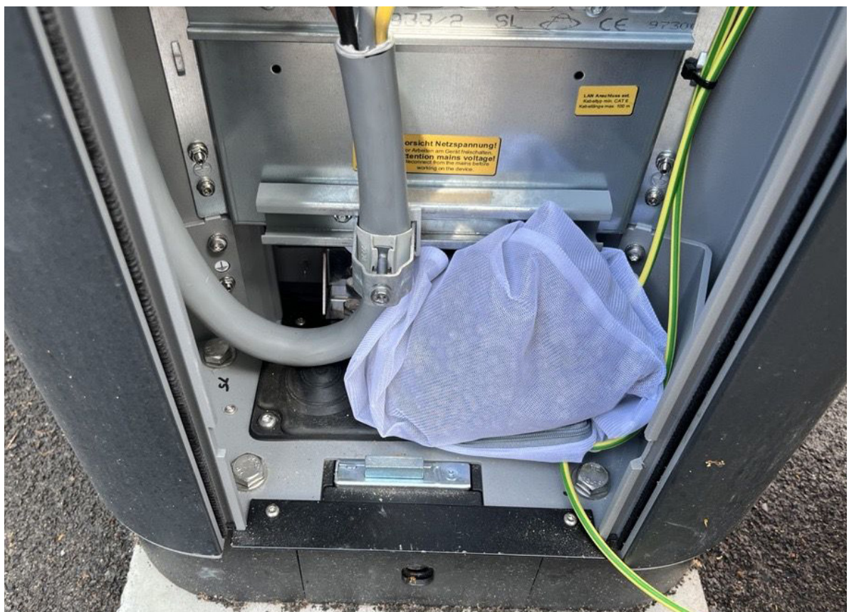
Abbildung 18: Beispiel einer Ladesäule mit ordnungsgemäßer Abdichtung und Sockelfüllmaterial
